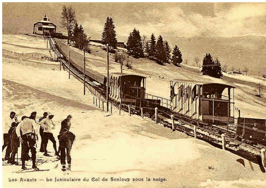
Schlittelbahn: Um Bobs zu transportieren, wurde 1910 die Standseilbahn vom Winterkurort Les Avants VD zum 500 Meter weit entfernten Hügel Sonloup errichtet.
